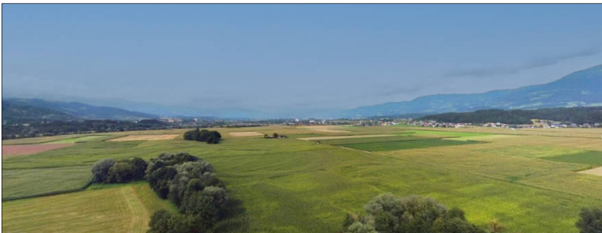
Lage im Raum - Blick über den weiten Talboden Richtung Norden (Quelle: google.streetview)
