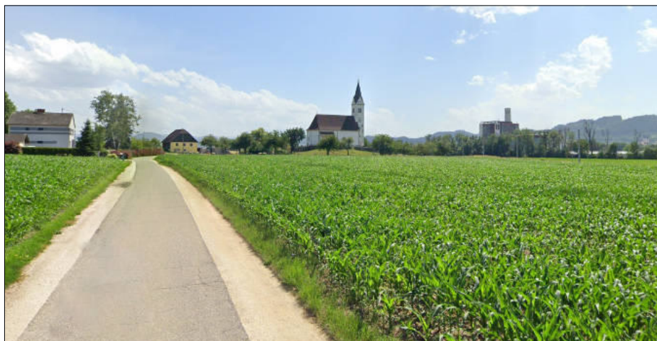
Siebending, ehem. Kohlekraftwerk (Quelle: google.streetview)
