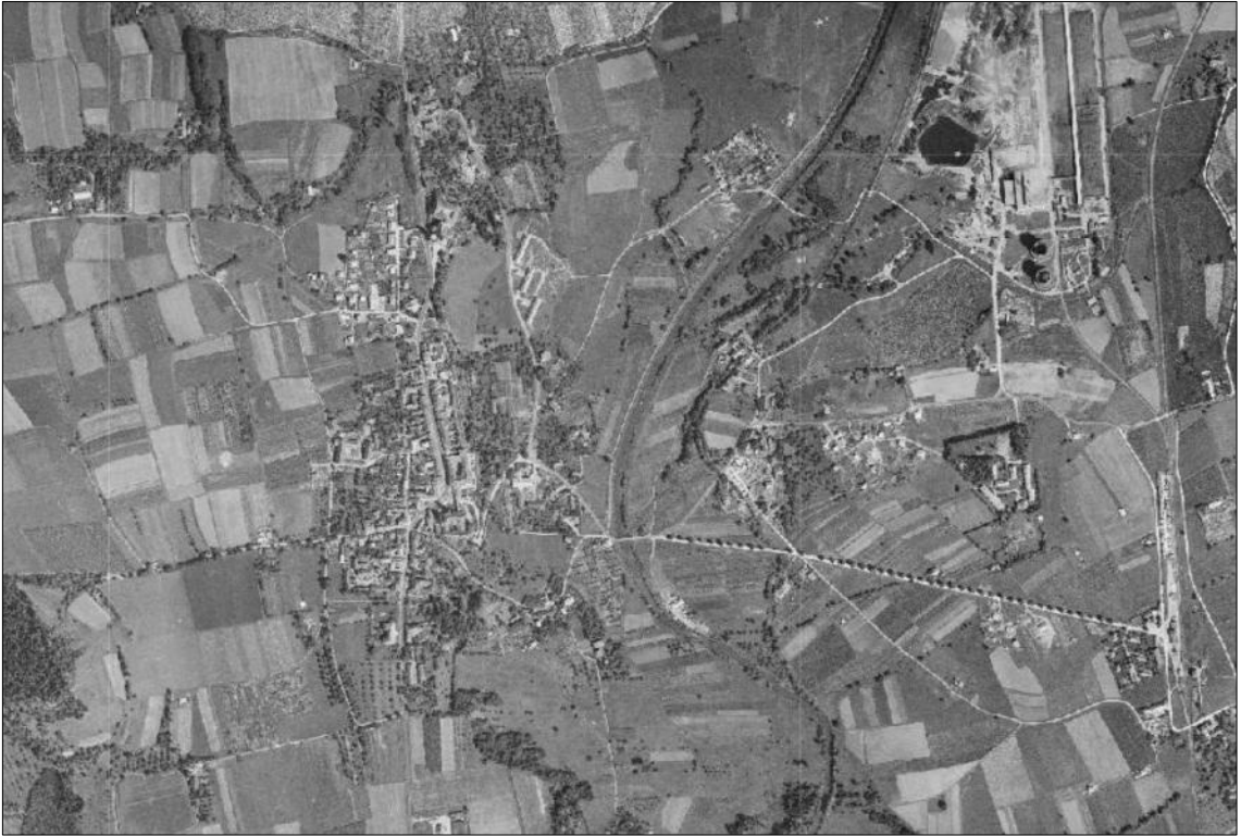
St. Andrä (Orthofoto, Befliegung 1952, Quelle: Kagis)
