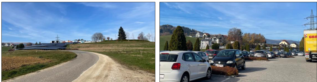
Links: Blick von Süden auf das Betriebsgelände (PV-Anlage); Rechts: Blick vom Parkplatz auf die westlich angrenzende Siedlung Kollegg (Quelle: Eigene Aufnahmen)
