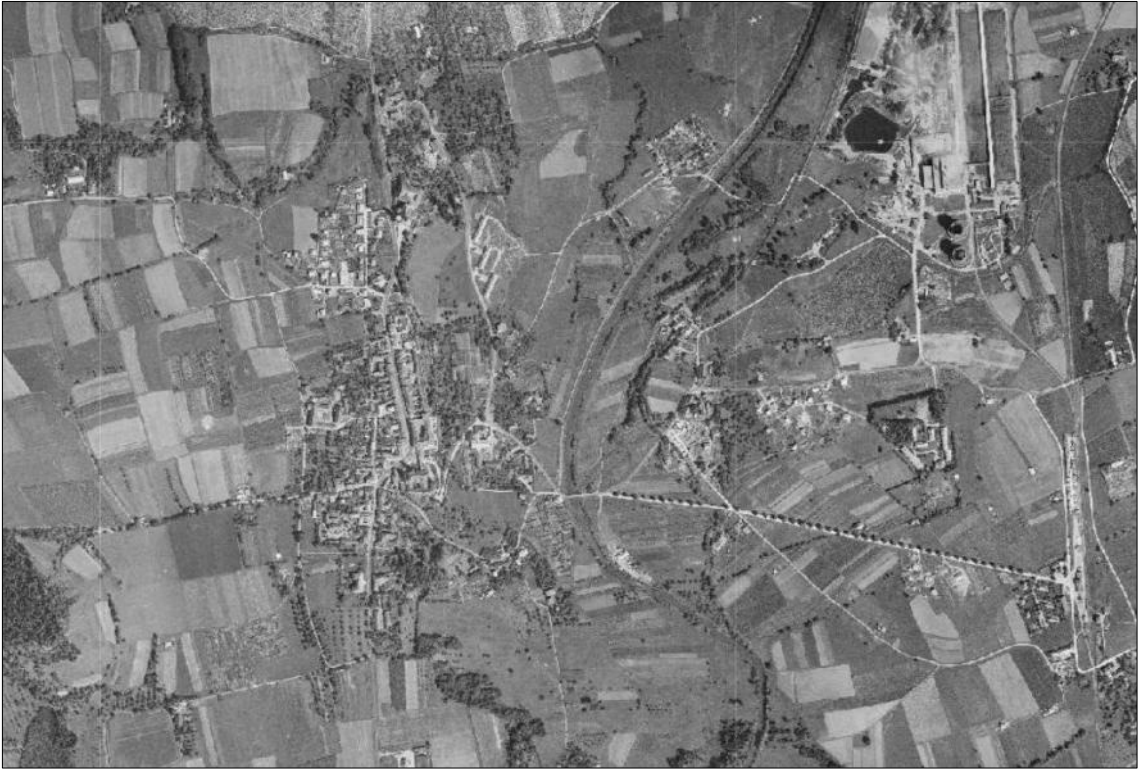
St. Andrä (Orthofoto, Befliegung 1952, Quelle: Kagis)
